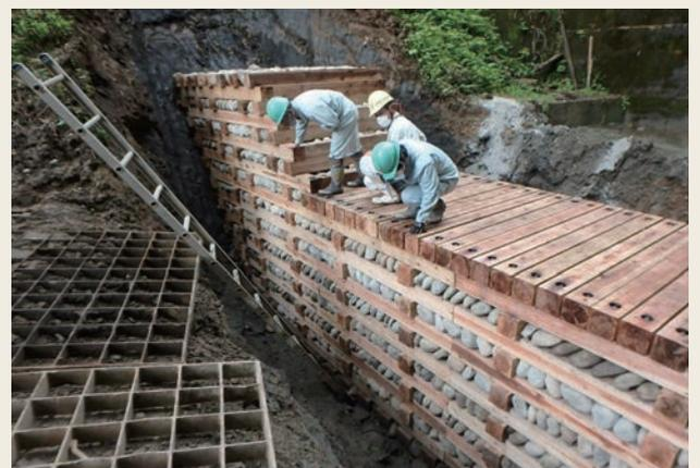
写真2 氷見市小竹における木製ダム施工中の様子
