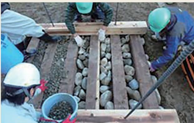
写真1 研究所内における木製ダムの試作状況
