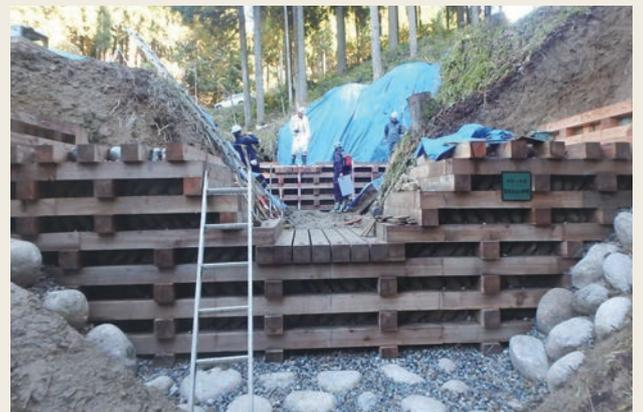
写真3 魚津市東城における木製ダム施工中の様子
